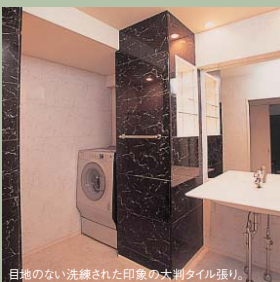
目地のない洗練された印象の大判タイル張り。
